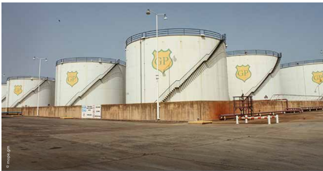
Le dépôt pétrolier de Mandinari, dans lequel le négociant genevois Totsa disposait de cuves de stockage.
