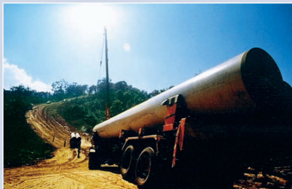
La construction du gazoduc de Yadana en Birmanie sur fond de guerre civile et de violation des droits humains. EarthRights International
